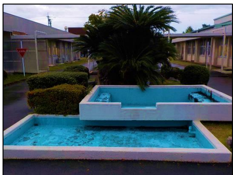
図9 使われなくなった防火水槽
